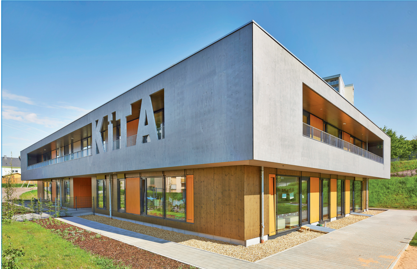
Architektonisch gelungen: die Kindertagesstätte in der Röntgenstraße
