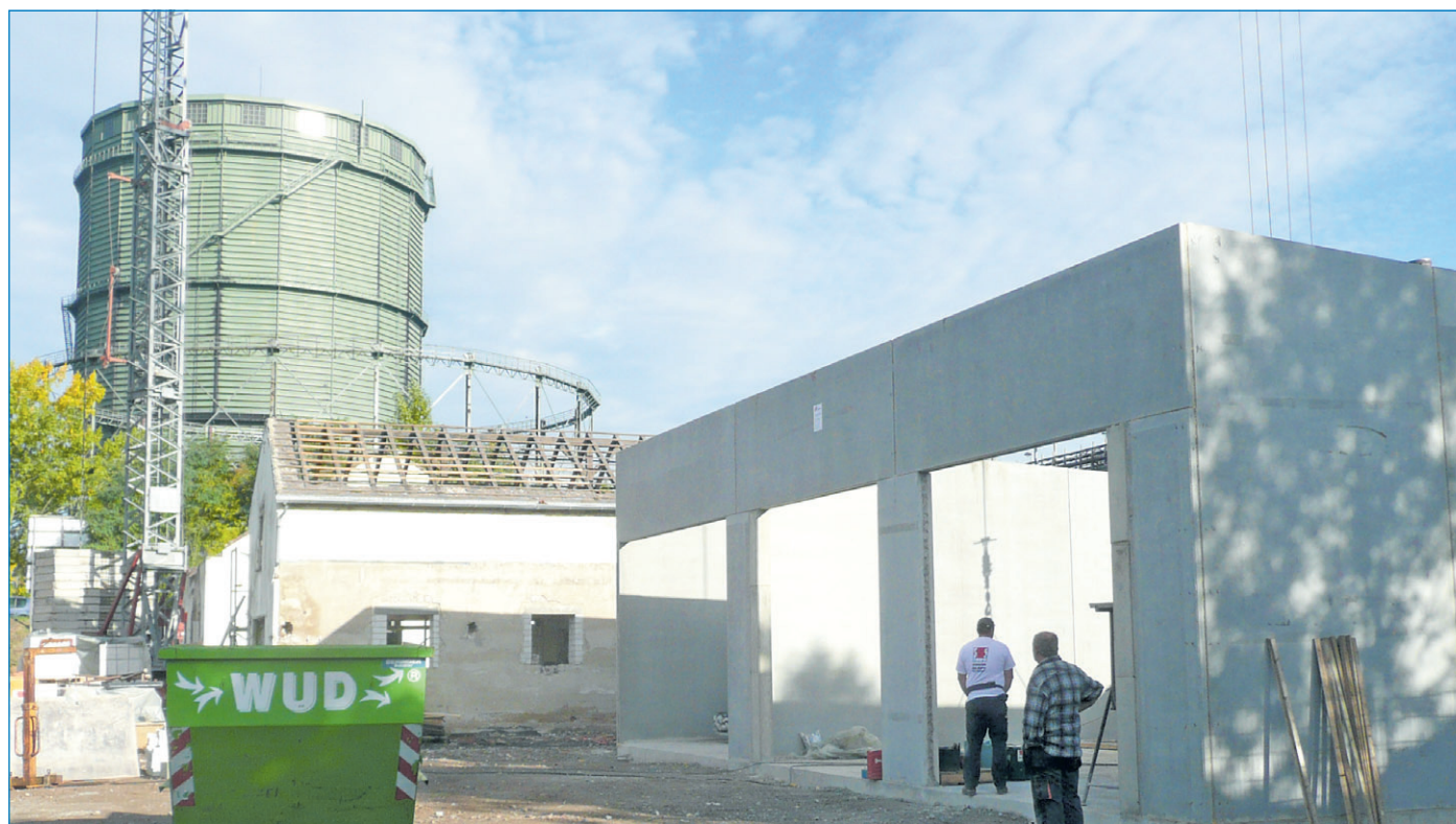
Blick auf die Baustelle des ehemaligen Schleusenwärtergehöfts
